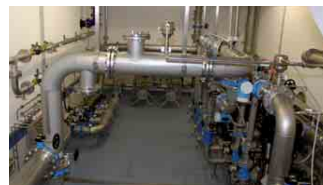
2012 wurde das neue Wasserwerk in Betrieb genommen
